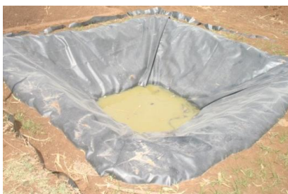
Fig.9. Geo-membrane lined pond
